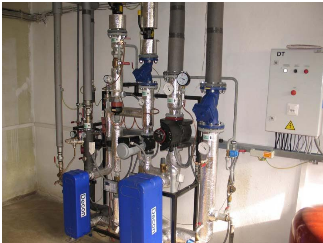
Obrázok 5 Kompaktná odovzdávacia stanica tepla
