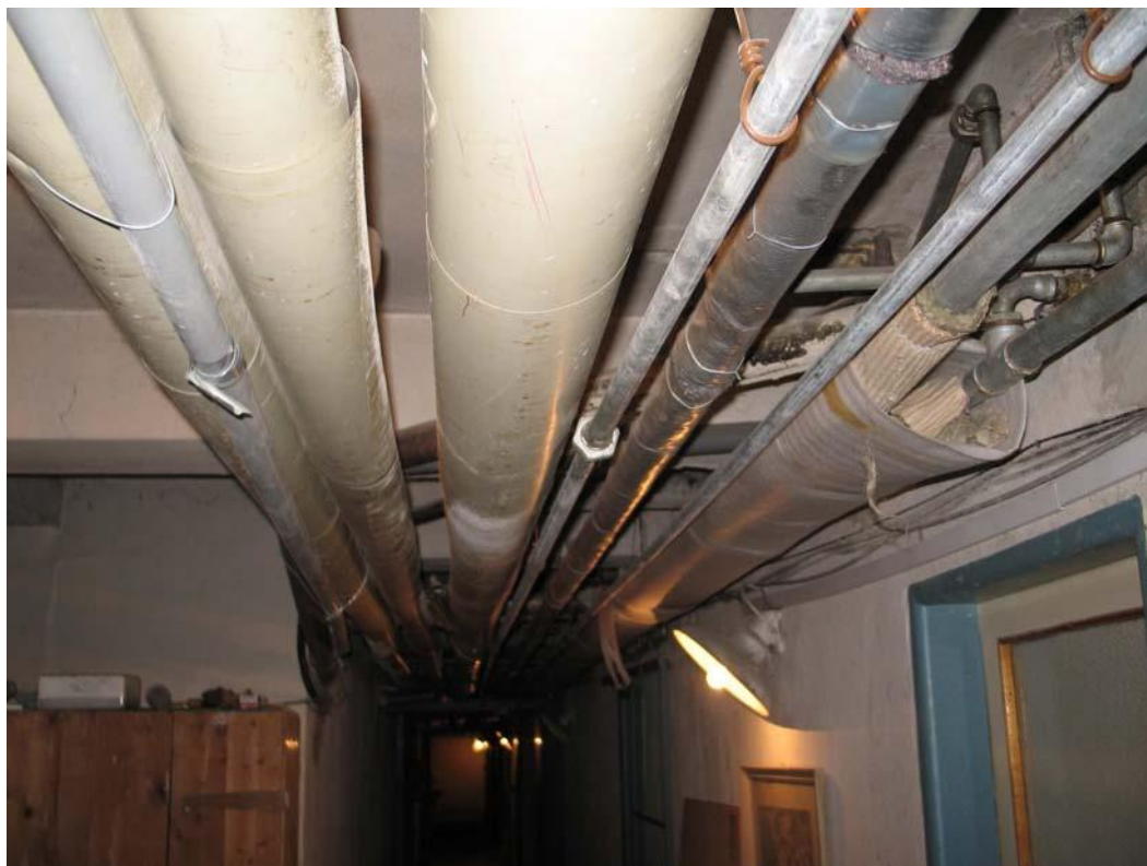
Obrázok 6 Ležatý rozvod tepla na vykurovanie a TV pod stropom suterénu
