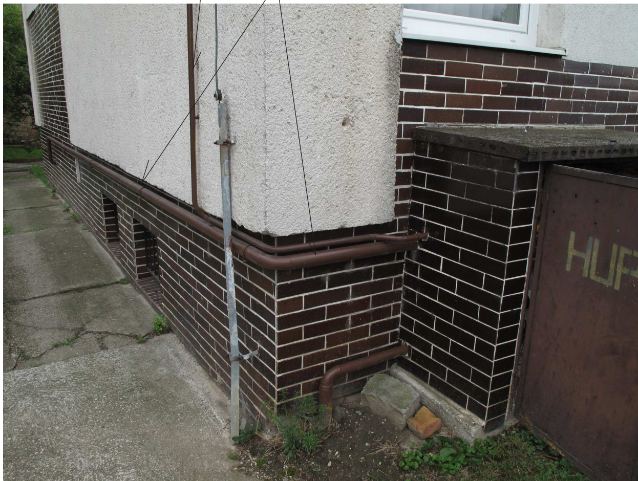
Demnotáž jestv. rozvodu NTL OCEĽ DN 50 na stene
