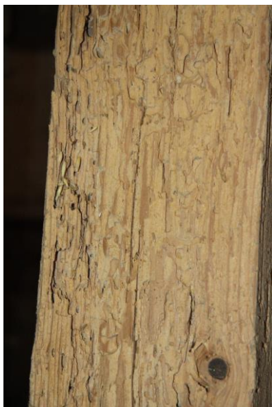
Stĺp napadnutý drevokazným hmyzom
