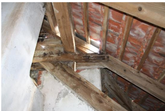
Poškodená plná väzba krovu – pri komíne
