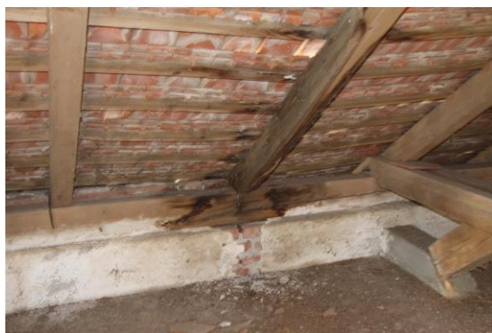
Poškodený prvok krovu – krokva a pomúrnica
