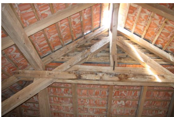
Poškodený nosný prvok krovu - klieština
