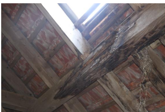
Narušený vážny trám - detail
