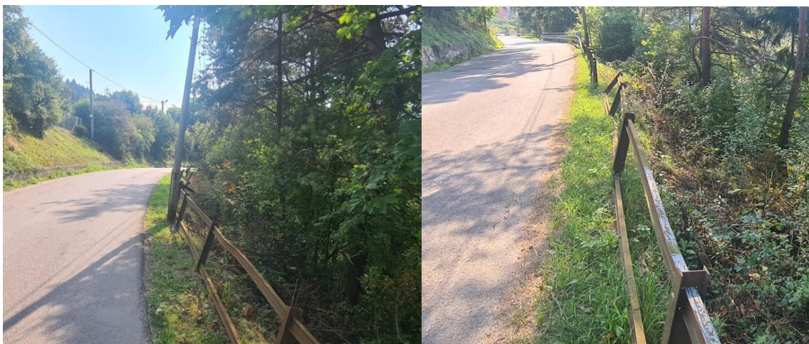
Obrázky deformácii na nespevnenej krajnici cesty III/2211
