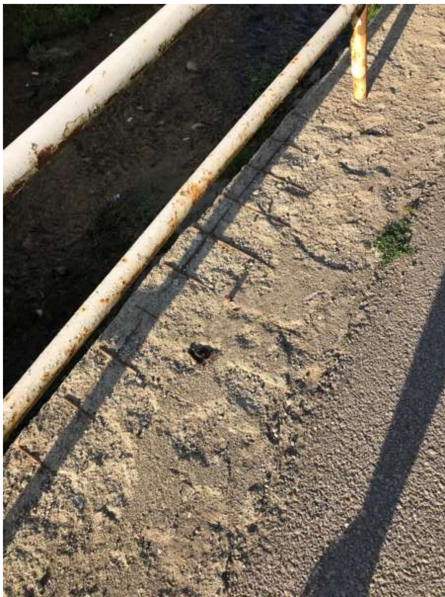
Obr. 2 – Obnažená výstuž oporného múru v úseku 2
