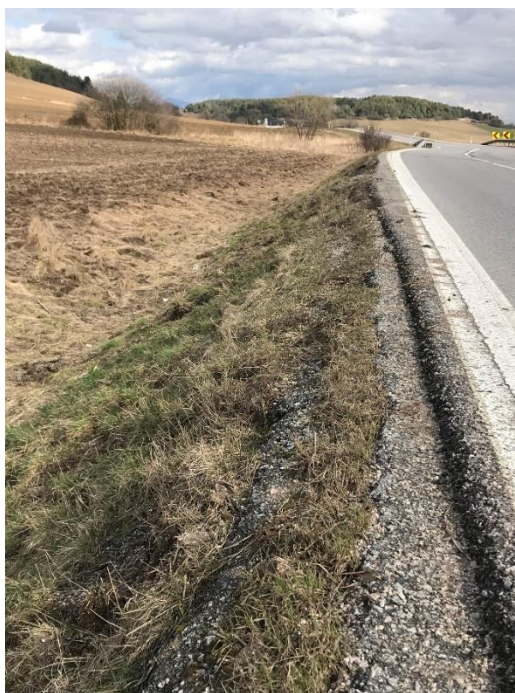
Obr. 2 – Lokálne upadnutie nespevnenej krajnice
