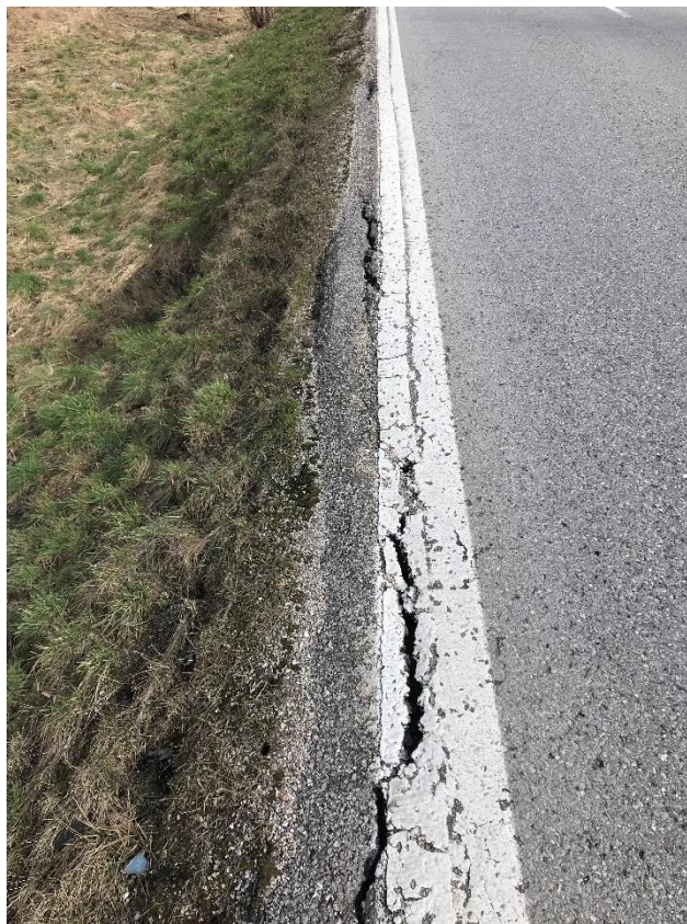
Obr. 3 – Porucha vozovky – odlamovanie okraja vozovky
