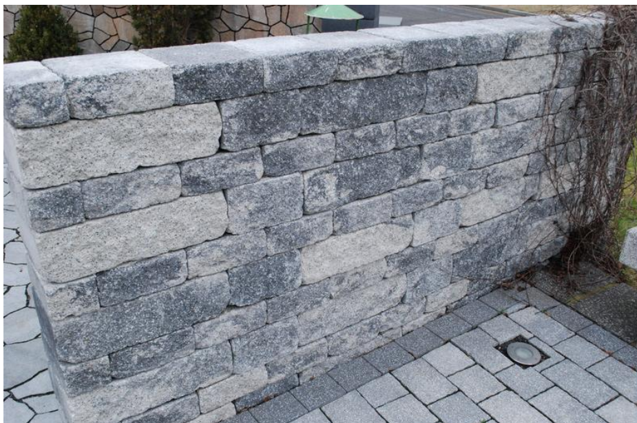
Oporné múriky – BOSS ANTIK (murovaná stena), hr.250 mm
