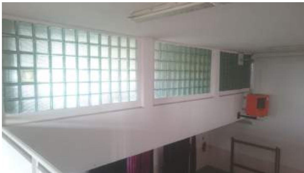
Obr. Int-02 _ Pohľad na sklobetónovú stenu a plynový ohrievač z balkóna - 2.NP (m. č. 2.02)
