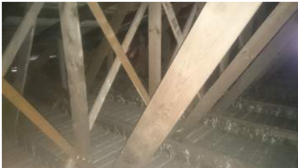
Obr. Int-14 _ Pohľad na drevené priehradové väzníky krovu strechy v podstrešnom priestore
