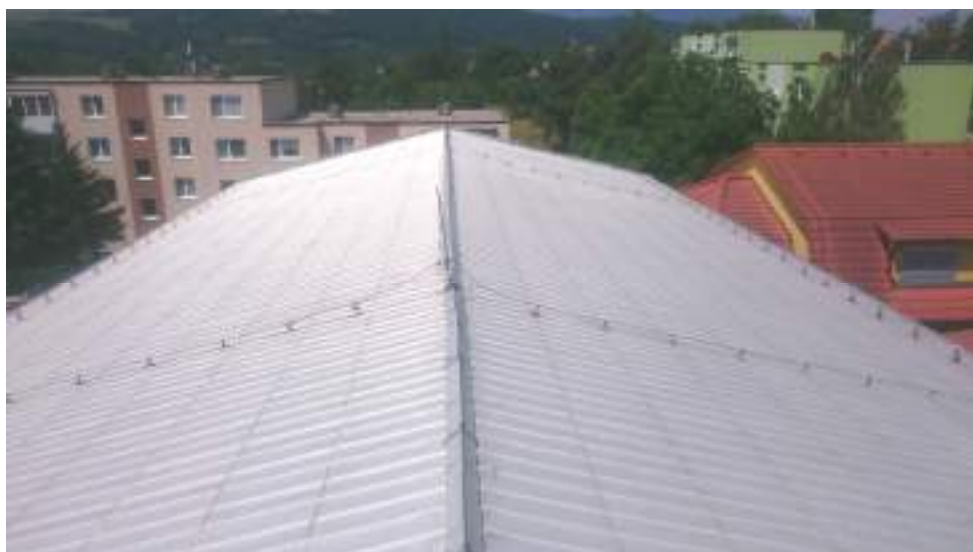
Obr. Ext-12 _ Pohľad na strechu budovy so strešnou krytinou z hliníkových šablón
