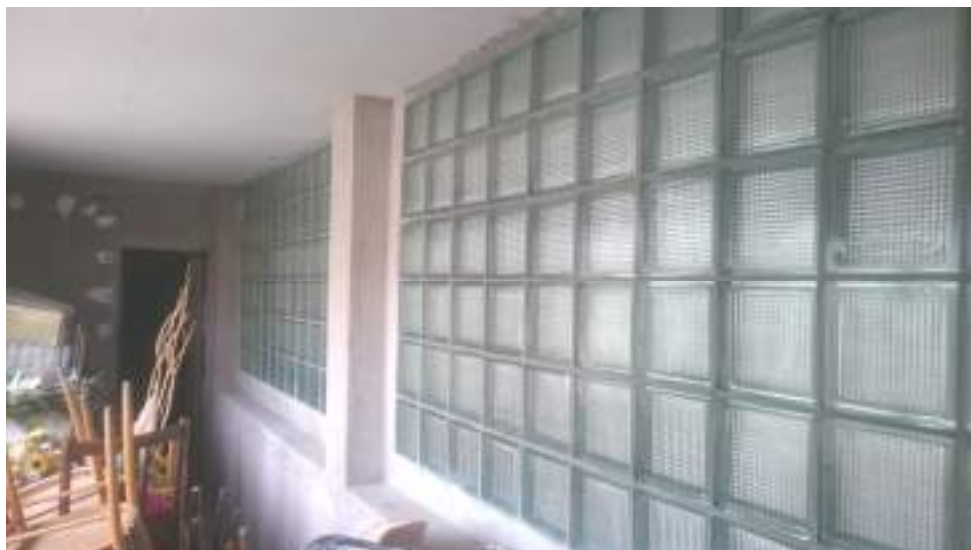
Obr. Int-01 _ Pohľad na sklobetónovú stenu v sklade - 2.NP (m. č. 2.04)
