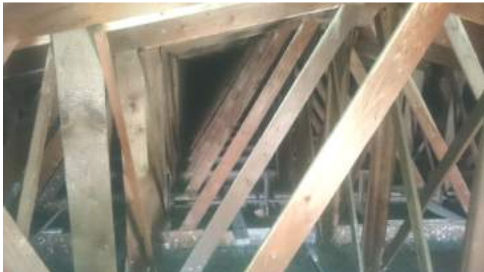
Obr. Int-13 _ Pohľad na drevené priehradové väzníky krovu strechy v podstrešnom priestore
